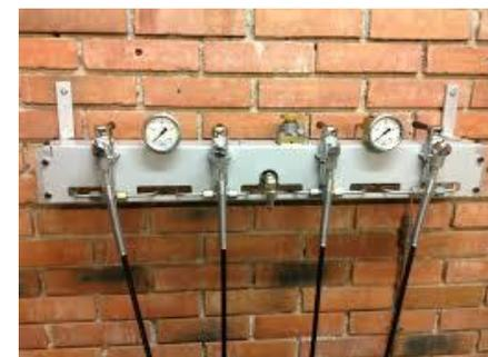
Accessoires de sécurité : **Soupape de sûreté de la rampe de chargement**
